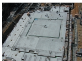
マットスラブ施工完了状況
