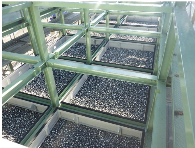
写真2 DHSろ床内部（担体充填後の状況）
