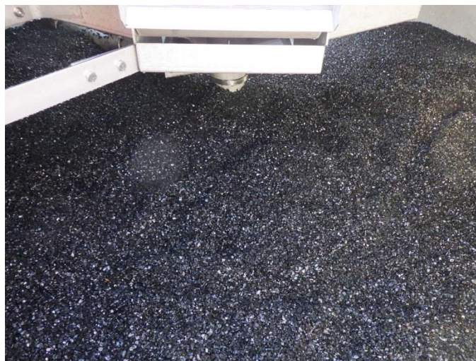
写真3 生物膜ろ過槽内部（担体充填後の状況）
