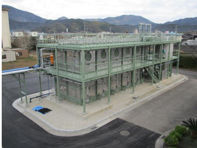
写真1 実証施設の外觀（左：DHSろ床、右：生物膜ろ過槽）
