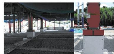
図3 新しい柱脚機構を用いた施工実験による工期短縮の確認
